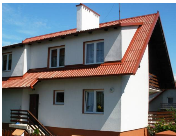
Rys. 9. Przykład zabezpieczenia wykonanego powłoką malarską. (źródło: materiały własne)
