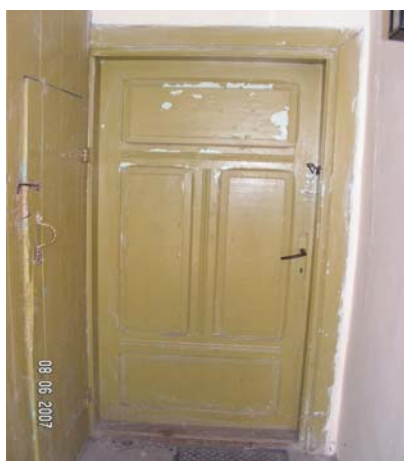
Drzwi wewnętrzne (po lewej do piwnicy, prosto do mniejszego pomieszczenia)
