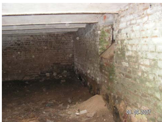
Piwnica świetlicy – możliwość wykorzystania na kotłownię
