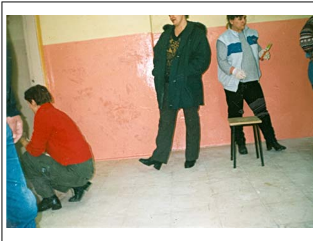
Marzec 2003 rok – rodzice wyremontowali stołówkę szkolną (położyli terakotę i odnowili ściany)
