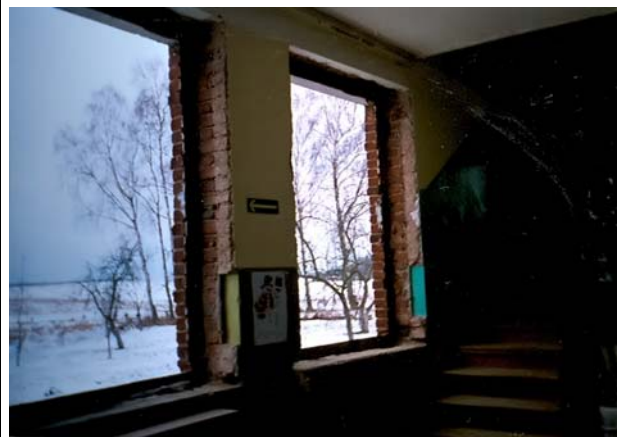
W czasie ferii zimowych w 2005 r. w szkole wymieniono okna na nowe oraz wyremontowano dach i wymieniono rynny
