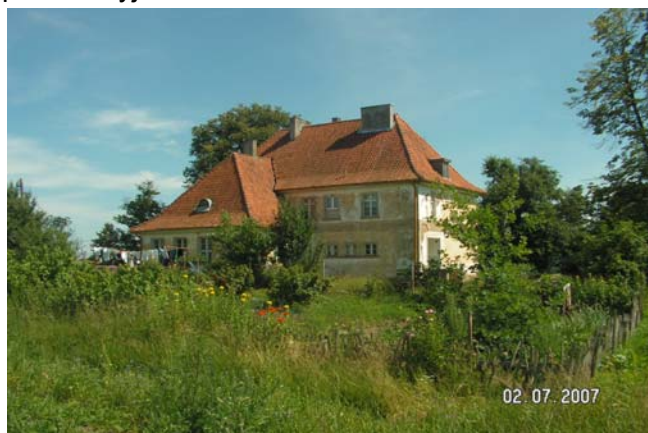
Budynek po byłej szkole podstawowej
