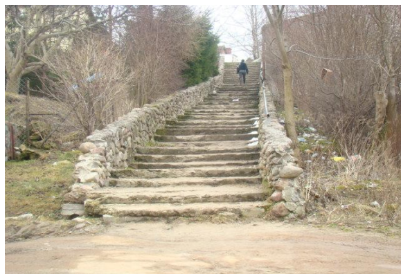
Fot. 16,17. Trakt pieszy – schody przy ulicy Młyńskiej.
