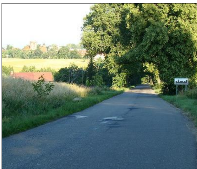
Fot. 9. Wjazd do Miłakowa od północnego zachodu – droga powiatowa nr 1162 N
